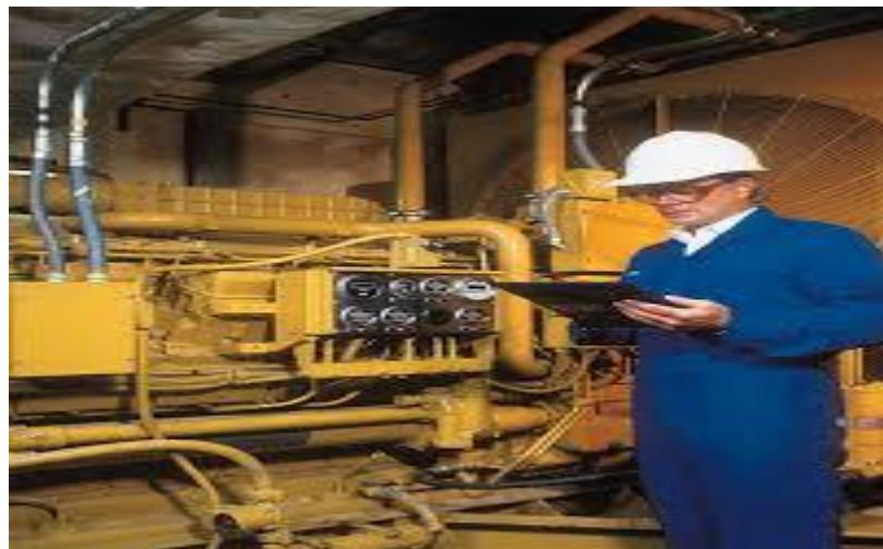
يتم تحديد قدرة المولد الاحتياطي المطلوب للمحطة وذلك بالاستعانة بمعامل الحمل Load Factor والمفترض بقيمة 0.8 وذلك بناء على وظيفة عمل المولد Prime Type ، يمكن الحصول على قيمة قدرة المولد المطلوب بعد قسمة قيمة اجمالي الاحمال المطلوبه للمحطة وهي 38.7 ك.وات على معامل الطلب فيصبح 48.4 ك.وات وبدراسة القيم المتاحة بشركات التوريد فسنجد اقرب قيمه لمولد يمكن توریده هو 60 ك.وات وبمعلوماته معامل القدرة يمكن الحصول على قيمة المولد بالكيلو فولت امير وتساوي 75 ك.ف.ا
