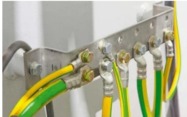
Equipotential bonding
