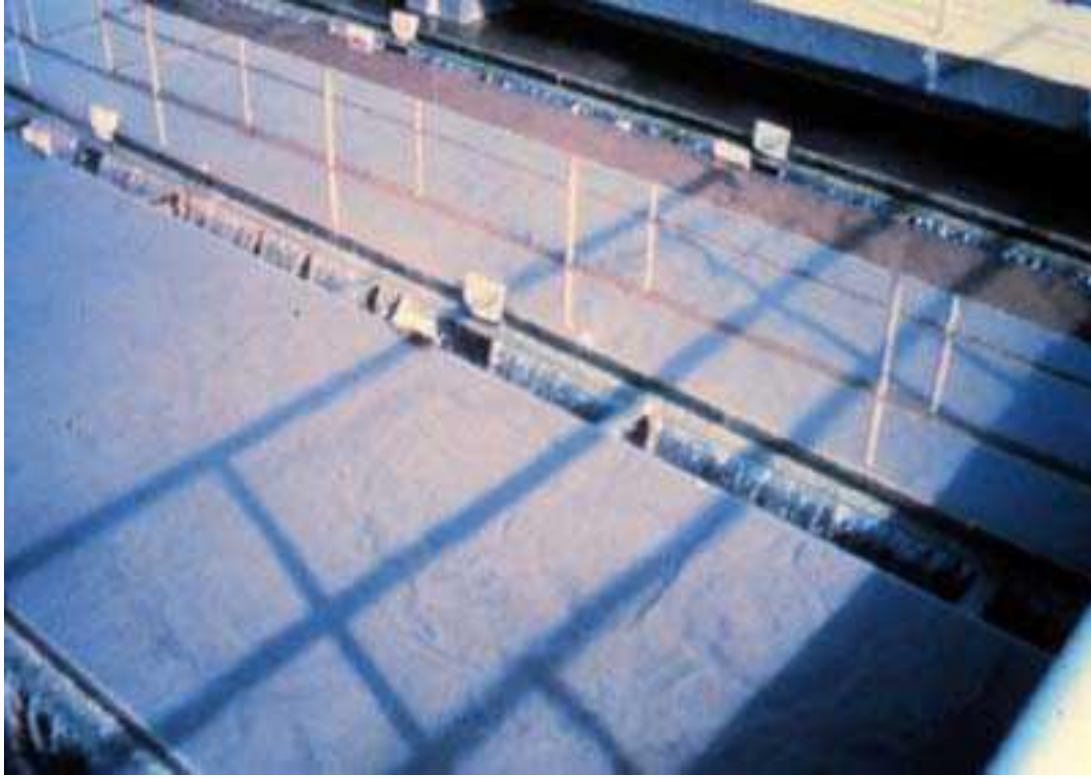
شكل رقم (5-9) أن سرعه ترسيب بالحماة بطيئة جدا
