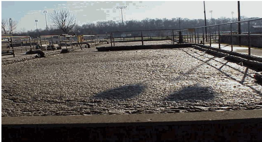
شكل رقم (4-5) وجود رغاوى بنيه كثيفه وقاتمته تميل الى اللون الأسود
