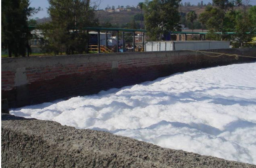
شكل رقم (5-1) وجود رغاوى بيضاء بأحواض التهوية في بداية التشغيل
