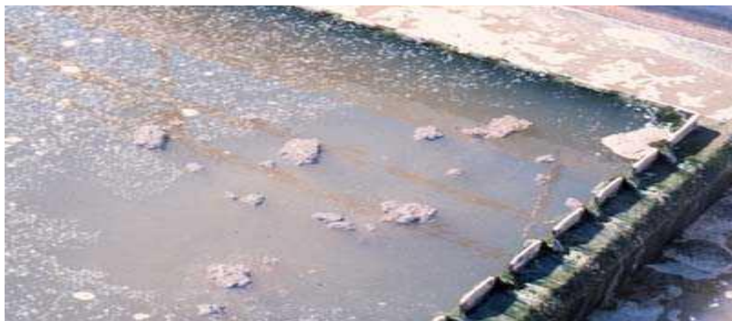
شكل رقم (5-7) وجود فقاعات غاز النيتروجين بالحماة وطفوها على السطح
