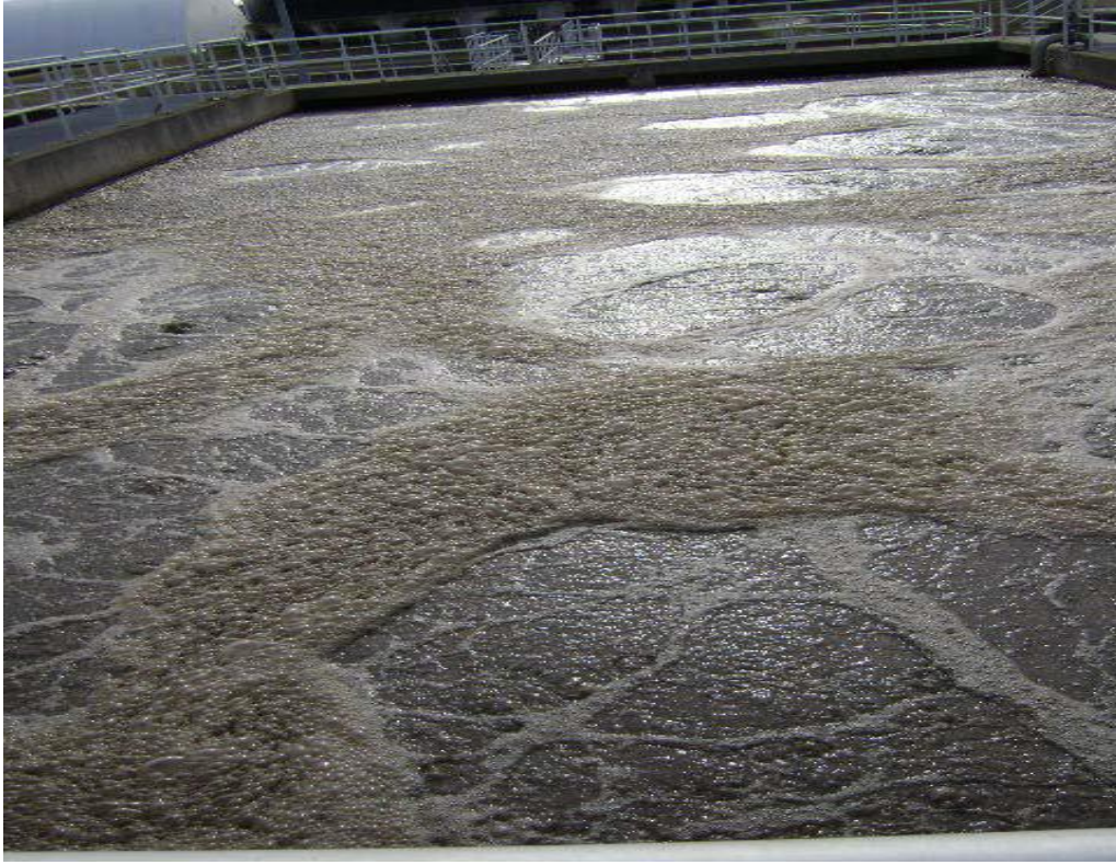
شكل رقم (5-6) وجود رغاوى سمراء بحوض التهوية
