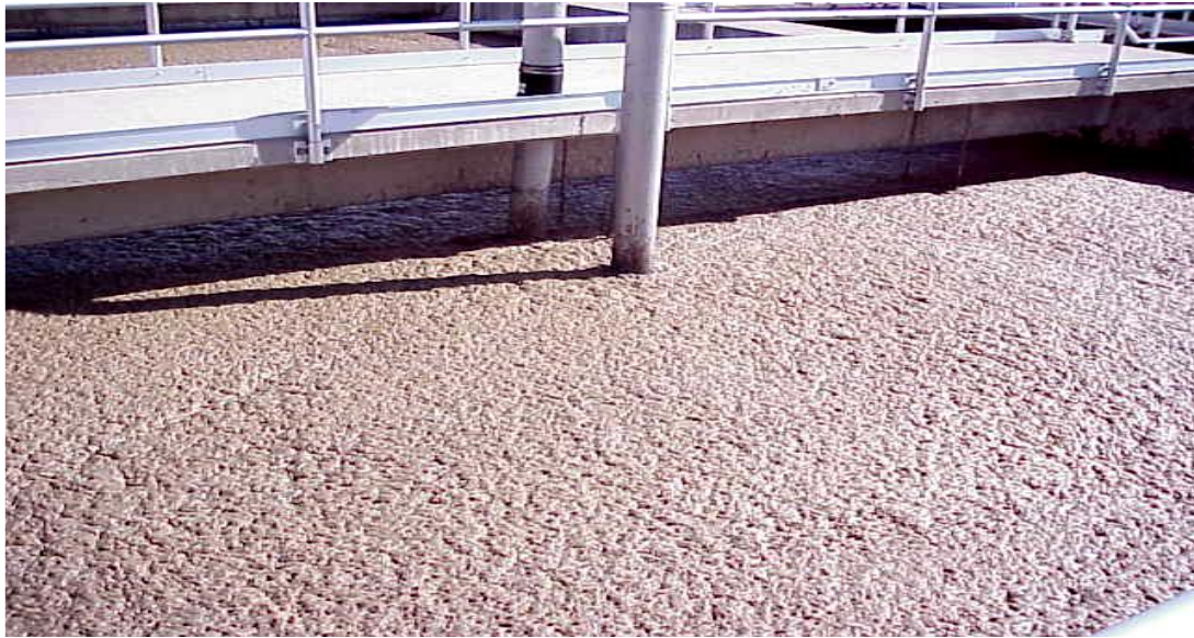
شكل رقم (4-5) وجود رغاوى بنيه كثيفه بحوض التهوية
