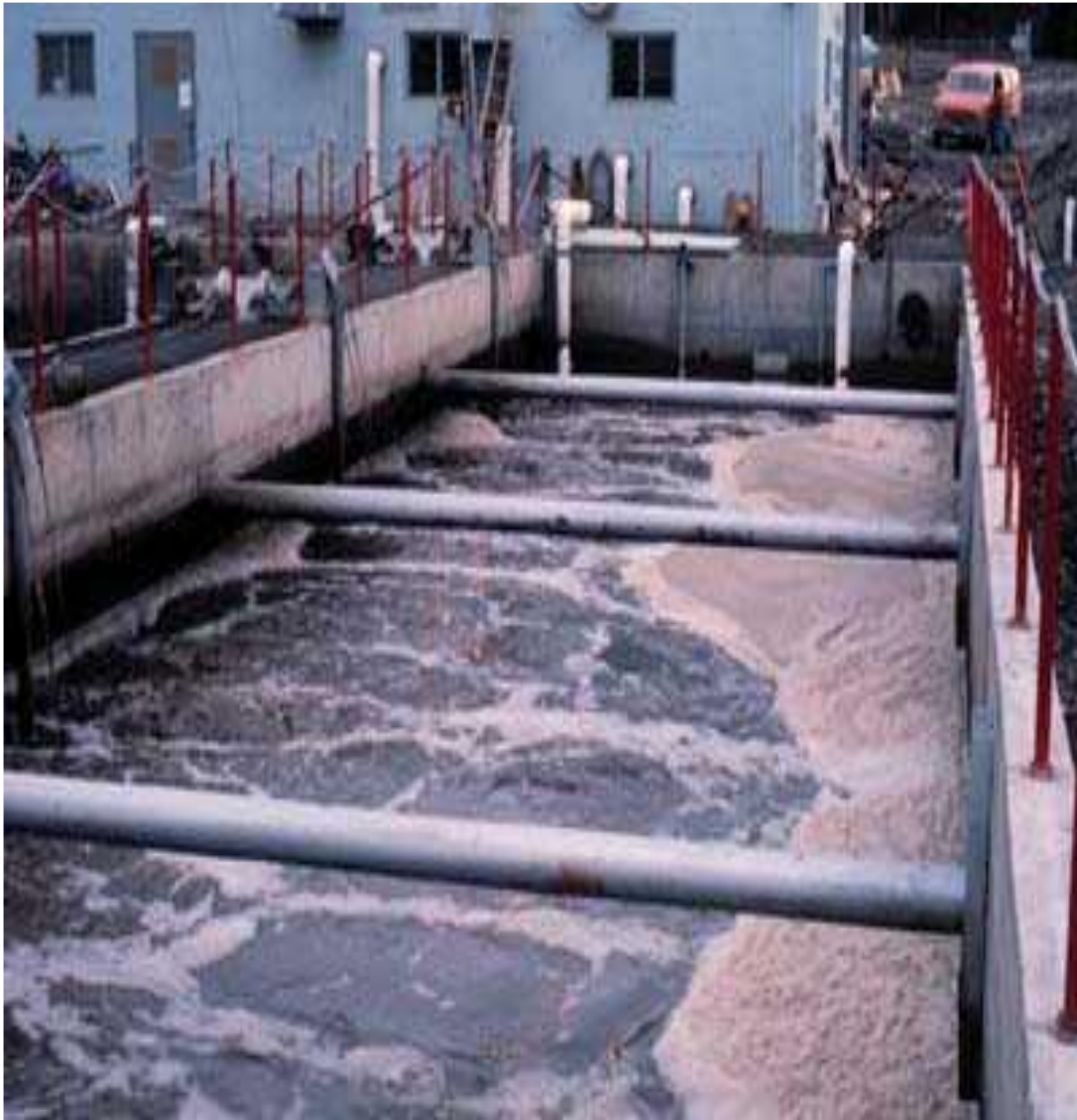
شكل رقم (5-3) بداية ظهور الرغاوى البنيه بحوض التهوية
