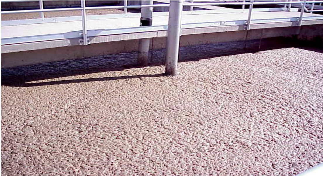
شكل رقم (4-5) وجود رغاوى بنيه كثيفه بحوض التهويه
