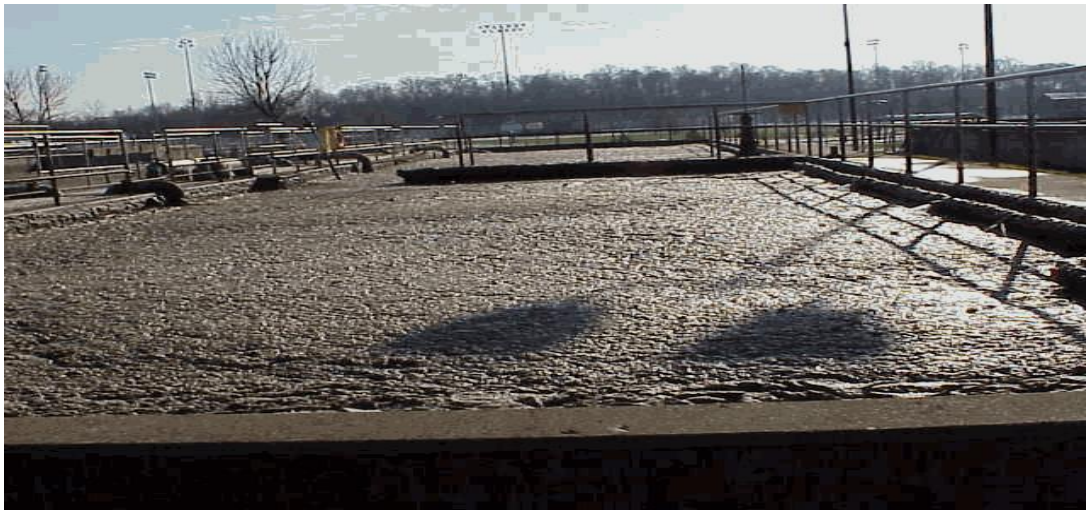
شكل رقم (4-5) وجود رغاوى بنيه كثيفه وقاتمته تميل الى اللون الأسود
