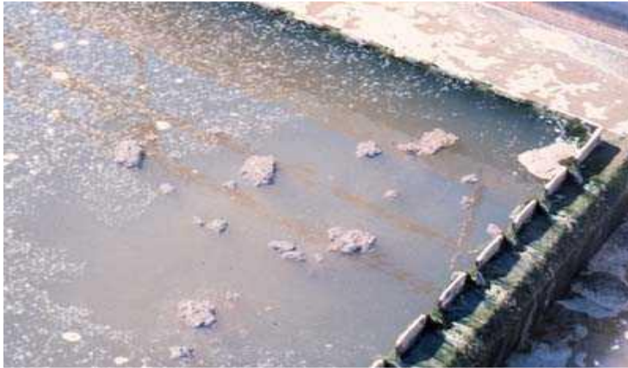
شكل رقم (5-7) وجود فقاعات غاز النيتروجين بالحمأ وطفوها على السطح
