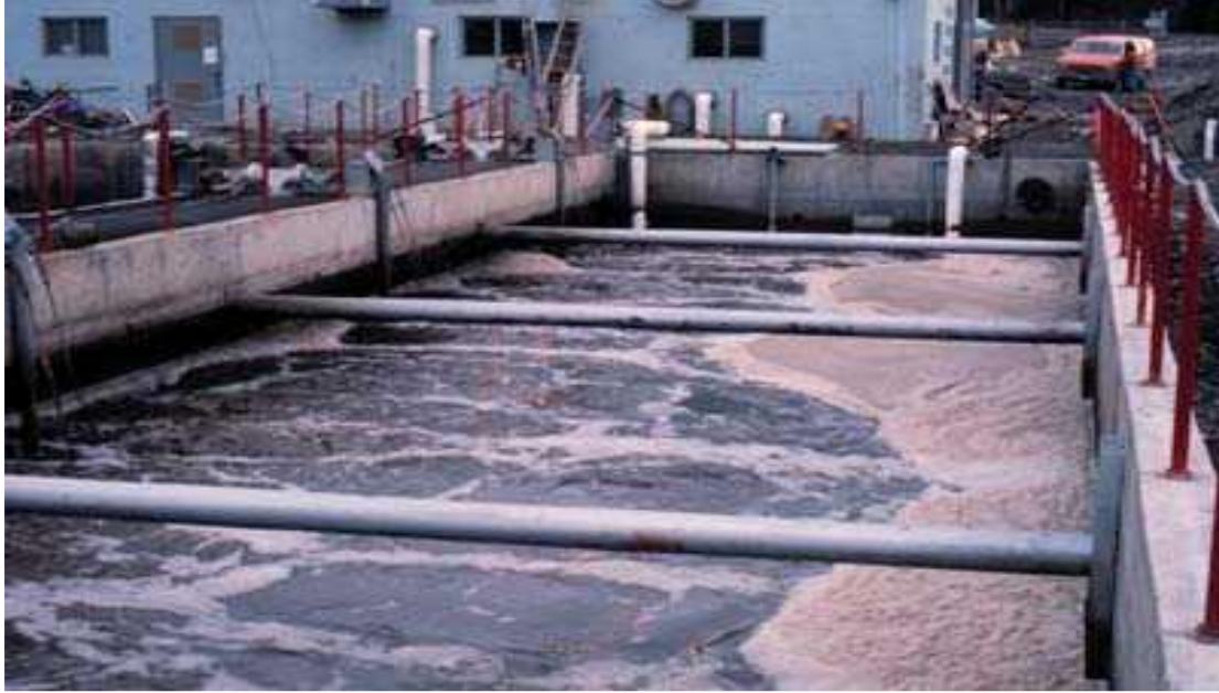
شكل رقم (3-5) بدايه ظهور الرغاوى البنيه بحوض التهويه
