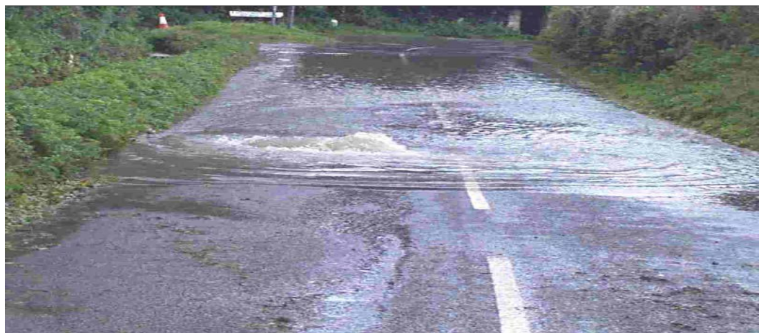
طفح مياه الصرف الصحي نتيجة لانسداد الشبك
