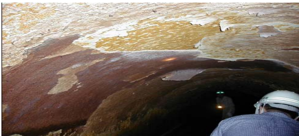
طفح مياه الصرف الصحي نتيجة لانسداد الشبك
