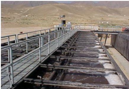
صورة رقم (10) ناشرات الهواء بحوض التهوية
