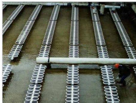
صورة رقم (10) ناشرات الهواء بحوض التهوية
